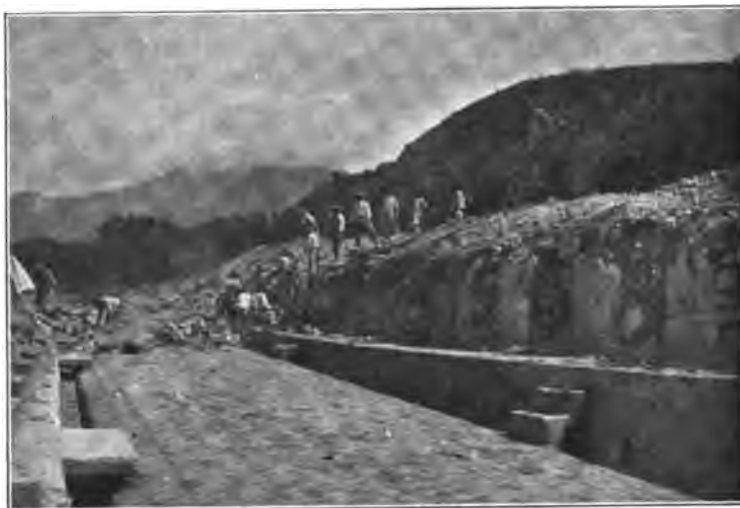
Fig. 261. — Le déblaiement de la partie septentrionale de la rue Victor-Hugo, en avril 1907 (Phot. Leboullanger).
